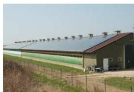
Im Jahr 2009 wurde eine Dachanlage über 240 kWp in Halberstadt, Sachsen-Anhalt, in Betrieb genommen. Es wurden beim Bau First Solar Module sowie Wechselrichter von SMA verwendet. Die Anlage erhält eine Einspeisevergütung von EUR 400/MWh. Der Solarpark leistete in den letzten 12 Monaten noch eine Produktion i.H.v. 837 kWh/kWp.
